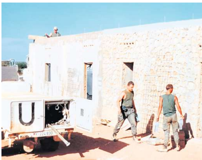
Instandsetzungsarbeiten an einer Schule.
