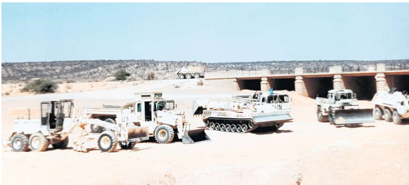
Baustelle im Wadi bei Nuurfanax.
