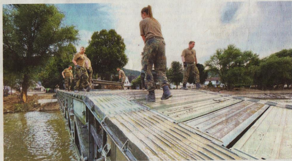
Gemeinsam packen alle an, um den Bau schnell fertigzustellen
