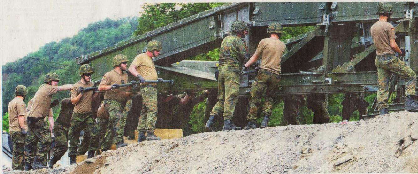
Die Soldaten legen beim Brückenbau kräftig Hand an.
